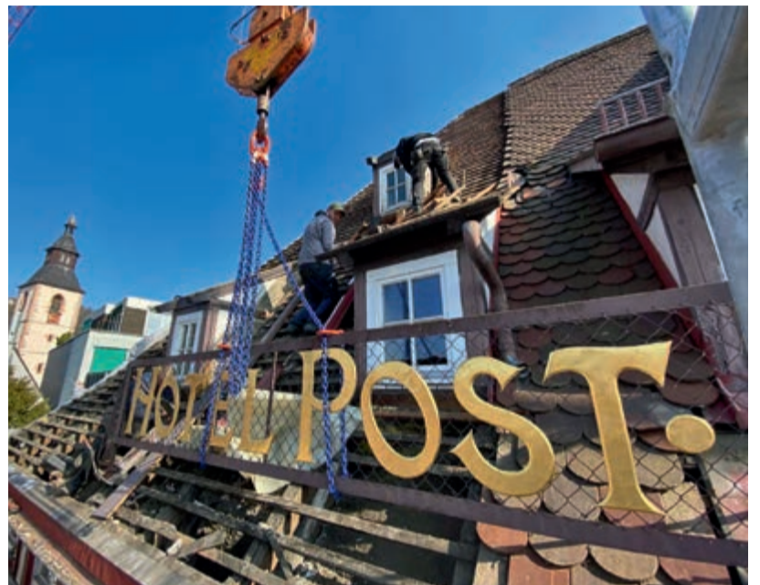
Sie ist über 300 Jahre alt: Die „Alte Post“ wurde von der Zimmerei Seidt restauriert und saniert und ihr Dach mit Biberschwanzziegeln von Jacobi-Walther neu eingedeckt.
