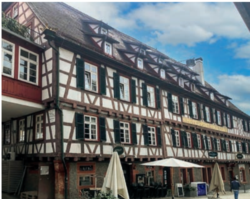
Sie ist über 300 Jahre alt: Die „Alte Post“ wurde von der Zimmerei Seidt restauriert und saniert und ihr Dach mit Biberschwanzziegeln von Jacobi-Walther neu eingedeckt.
